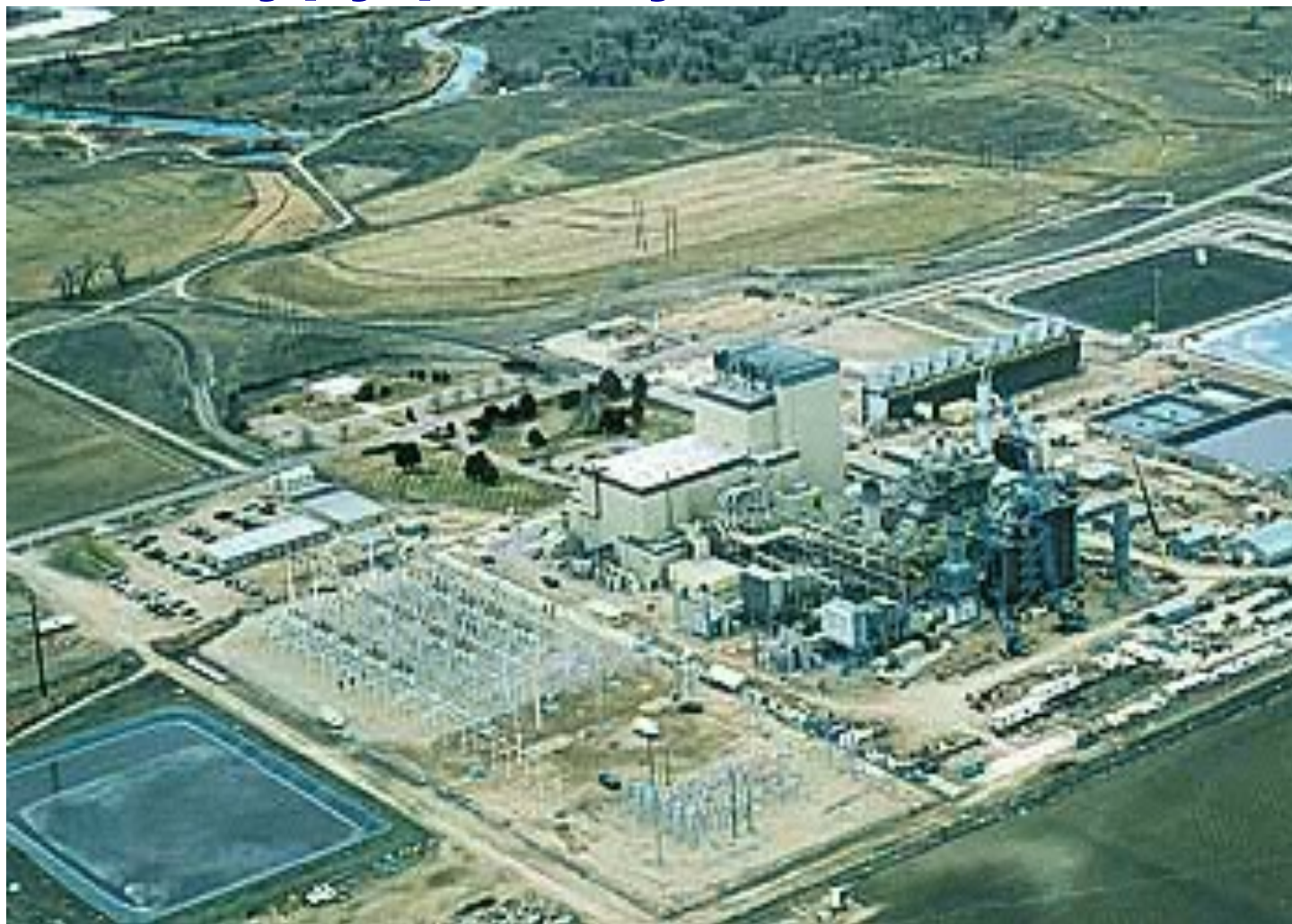
Fort Saint-Vrain, USA 300 MWe 1976-89
